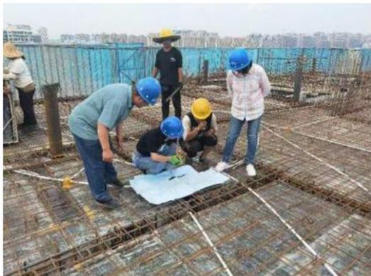
30 层顶板钢筋隐蔽验收
