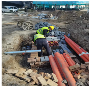
开元北小区升井
